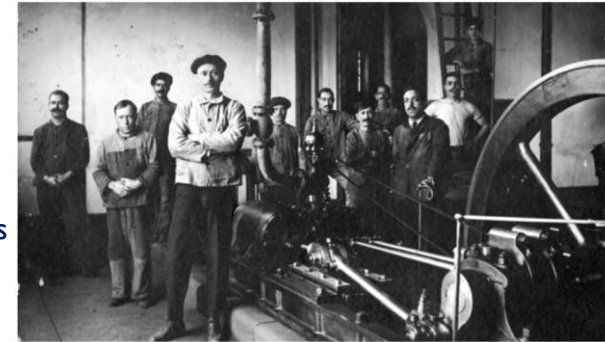
Operários da CAL junto de máquina a vapor
